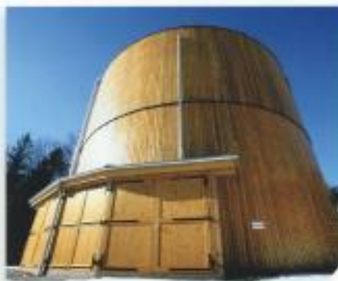
Les boues introduites dans ce digesteur se dégradent et produisent du biogaz (méthane) qui va alimenter chaudière et cogénérateur.
