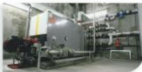
Alimentée avec du biogaz, la chaudière produit une chaleur utilisée sur place, pour le process et le chauffage des locaux.
