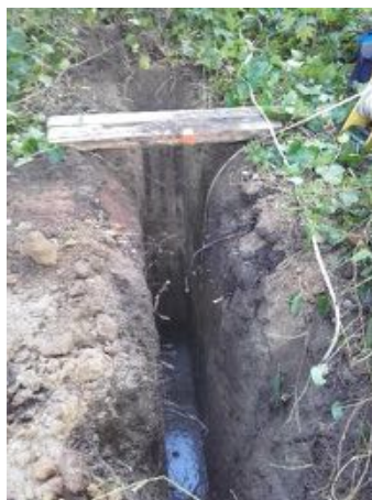
Figure 11 : Exemple de tranchée réalisée pour un essai d'infiltration (photographie BURGEAP 2016)
