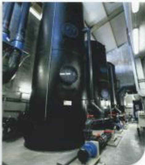
L'air collecté dans la station traverse ces tours de lavage qui suppriment les odeurs qu'il peut contenir.
