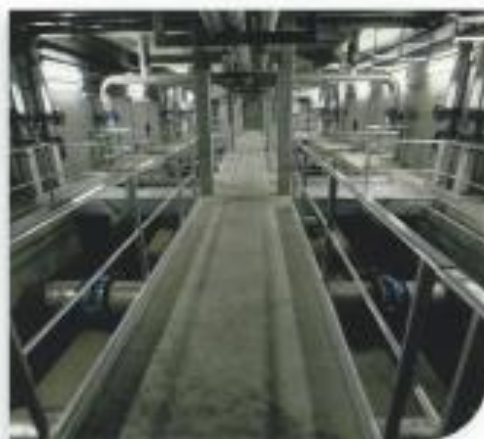
L'effluent pénètre dans le Biostyr®, en partie brute : la pollution dissoute y sera dégradée et transformée en boue par les bactéries.
