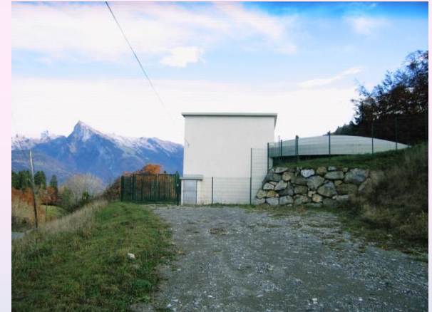
Réservoir de la Biolle 1 000 m 3
