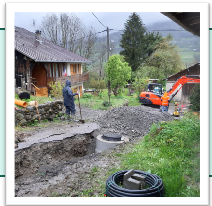
Travaux d'assainissement à Cellières
