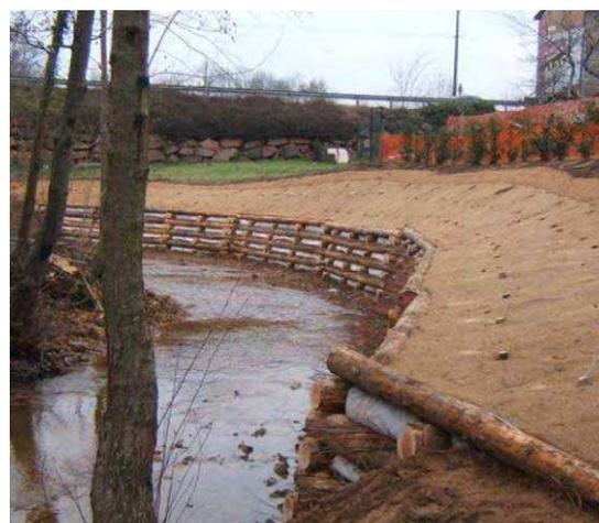
**Figure 67 : Caisson végétalisé à double paroi**
