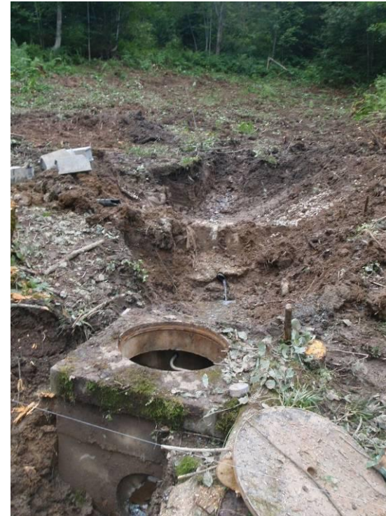
Réfection du captage haut du Châtelard
