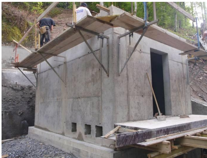
Génie-civil en cours de réalisation
