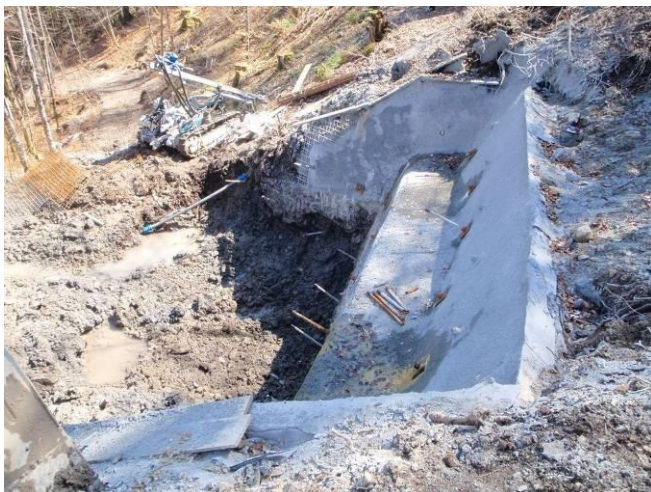
Réalisation de la paroi clouée à proximité de l'ouvrage existant
