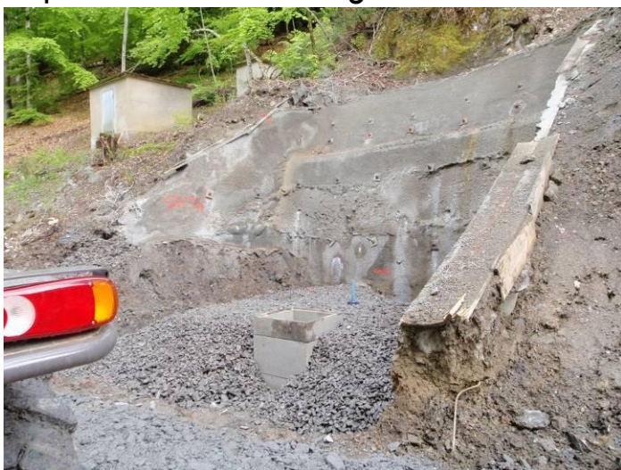
Réalisation de la paroi clouée à proximité de l'ouvrage existant
