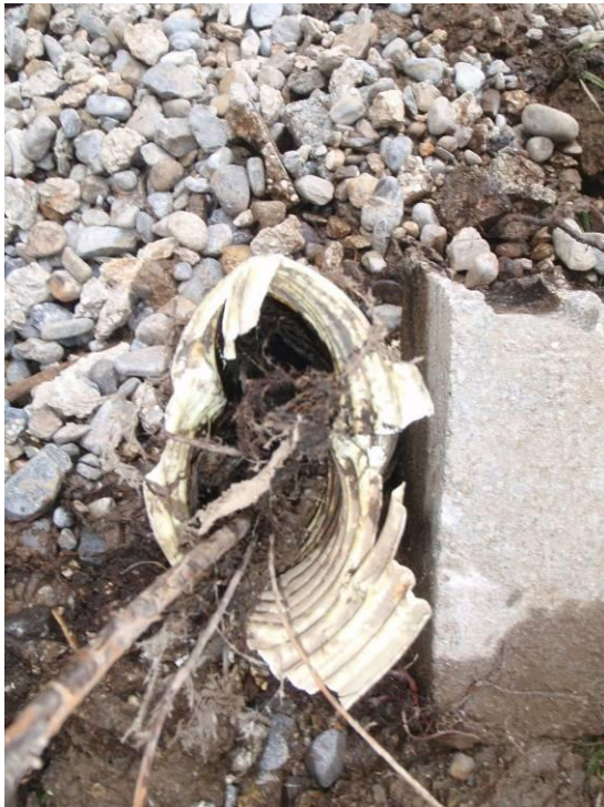
Drain existant plein de queues de renard
