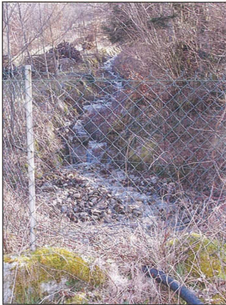
Figure 16: Plage de dépôt située en amont immédiat du chef-lieu.
