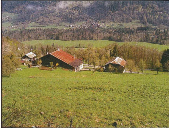
Figure 8: Habitations du Hameau CHEZ FILLOU touchées par la coulée boueuse de février 1990 (vue depuis la voie communale dominant le secteur).
