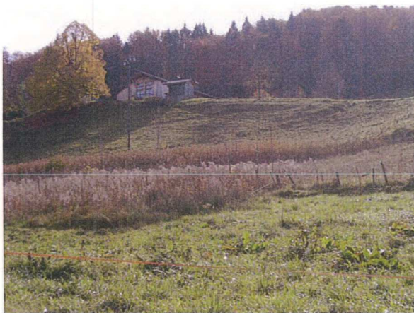
Figure 11: Pentcs instables et zone humide en contre-bas immédiat du hameau de PLON.
